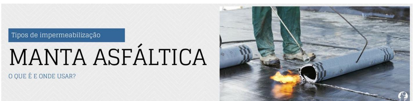
A **manta asfáltica** é um dos sistemas de impermeabilização flexíveis mais utilizados em todo país, e é indicado para os mais diversos elementos estruturais como lajes, vigas, reservatórios, piscinas, e é facilmente encontrado no mercado.
