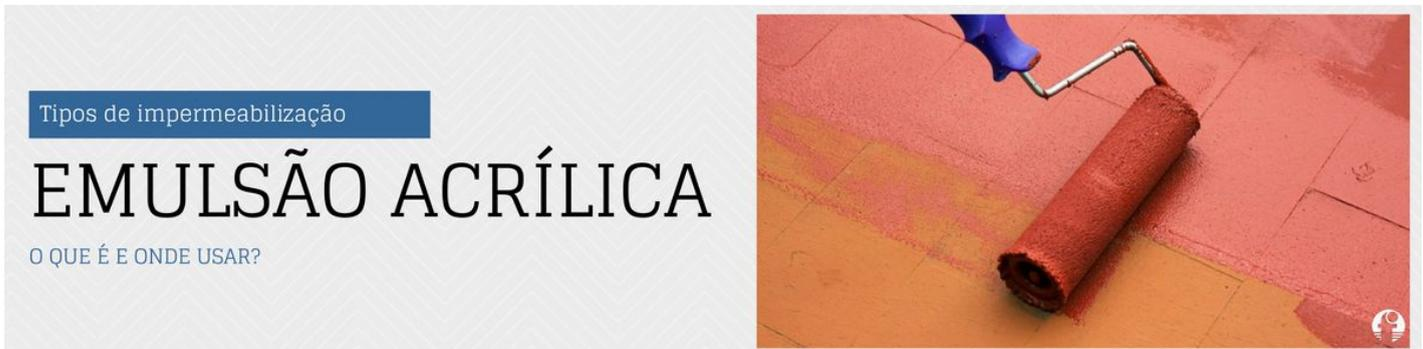
Este tipo de sistema de impermeabilização é classificado como **flexível**, podendo ser utilizado em áreas sujeitas à movimentação térmica.
